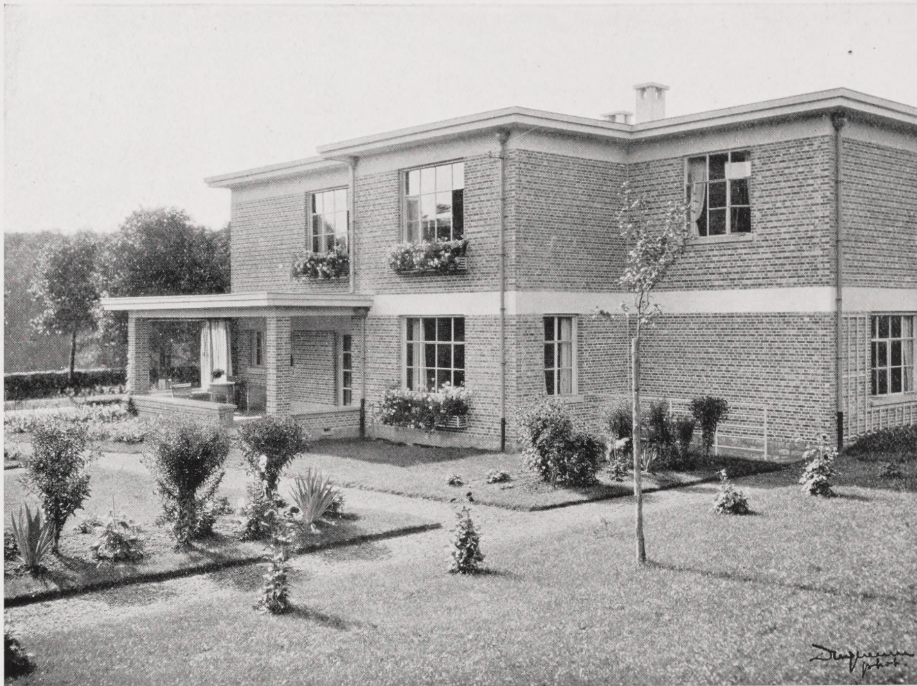
Villa à Heusy-Verviers, vue prise de l'est.
